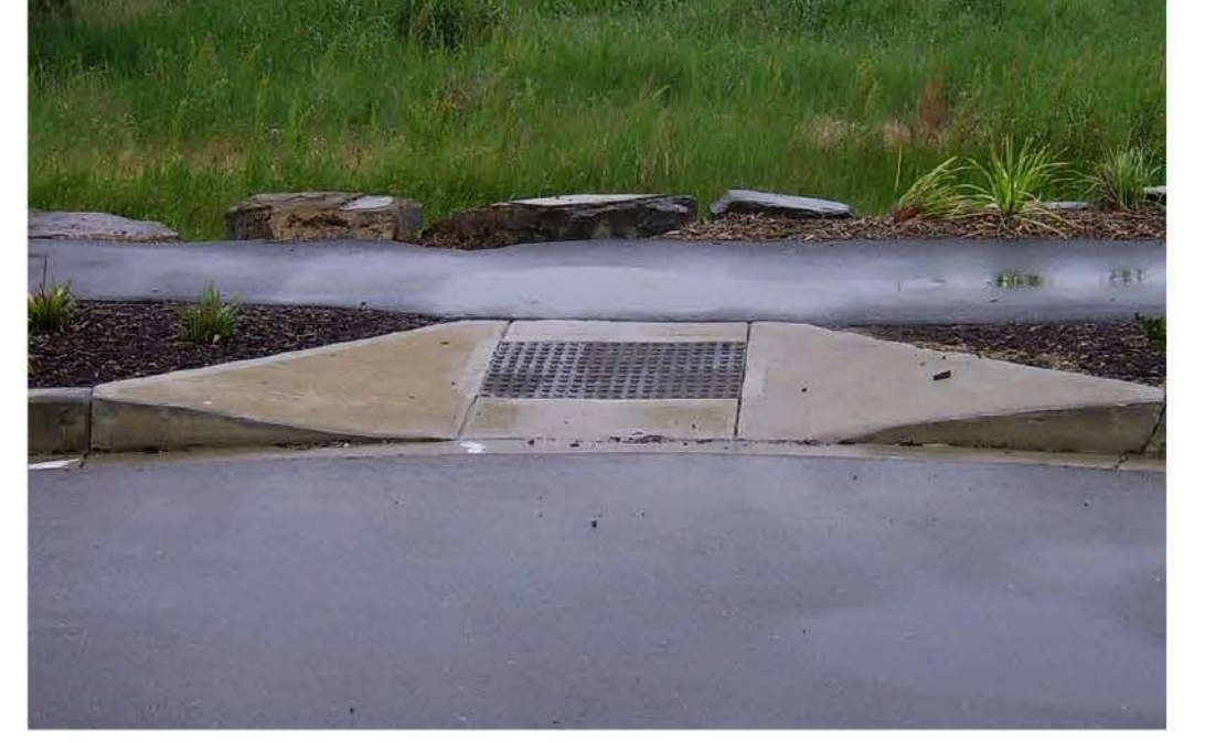
ADA curb cuts
